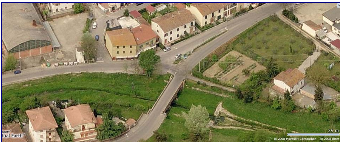
Ripresa aerea in direzione ovest dell'incrocio tra Via Val d'Orme e Via Ormicello.
