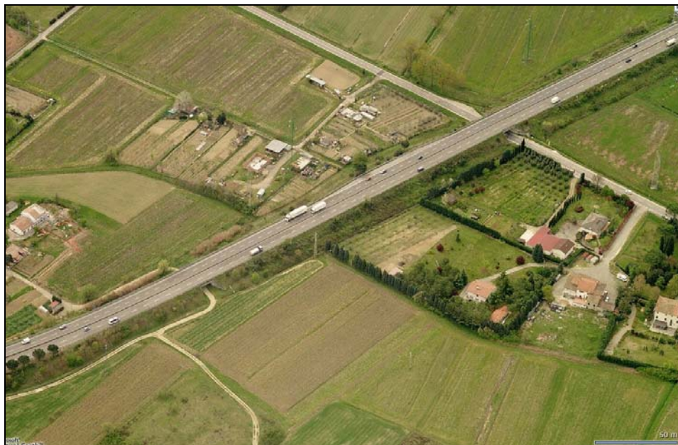
Foto aerea in direzione ovest del sottopassaggio della SGC Fi-Pi-Li sulla Via di Pratella; in alto a destra si vede quello sulla Via della Piovola.
