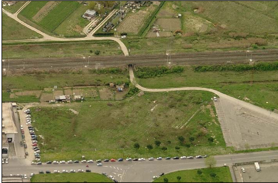
Foto aerea in direzione sud del sottopassaggio della ferrovia Firenze-Pisa sulla Via di Pratella; in basso è visibile l'incrocio a "T" tra Via Giuntini e Via Luigi dalla Piccola.
