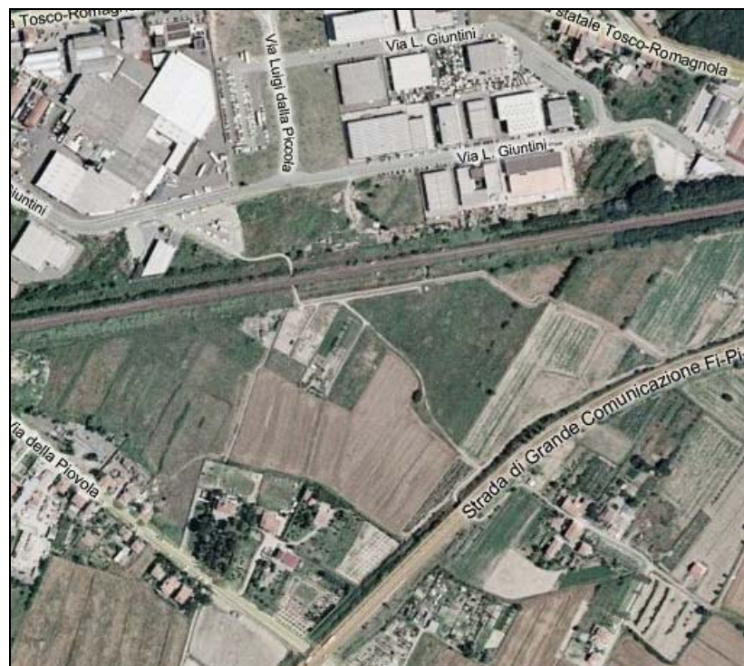
Ripresa da satellite di dettaglio della zona in cui si dovrebbe realizzare la nuova bretella stradale.
