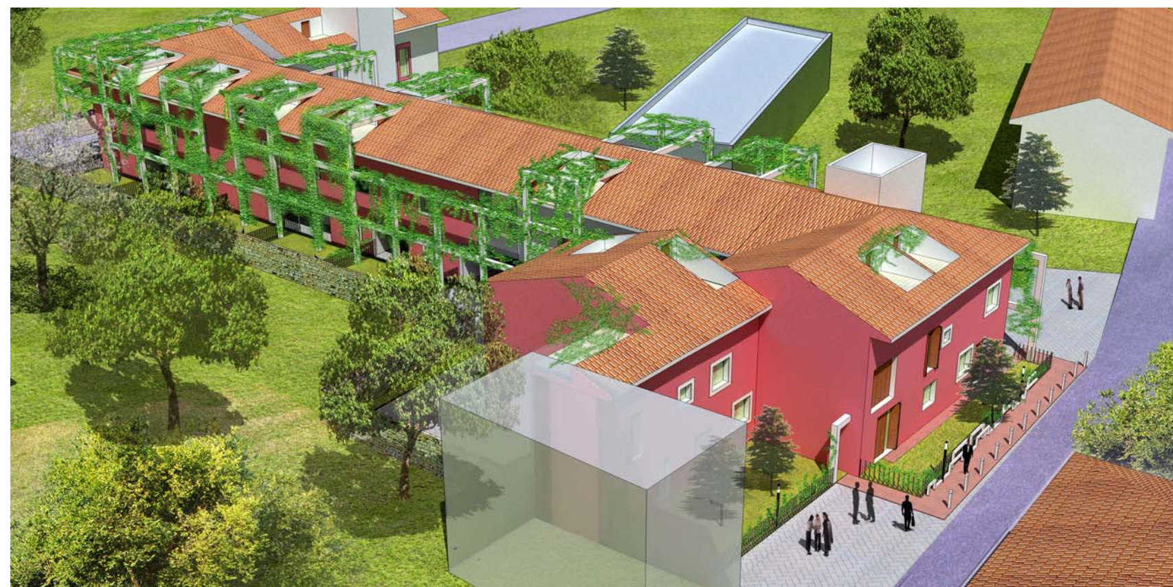
Vista fronte interno Via Tosco Romagnola-Via Giro delle Mura Sud
